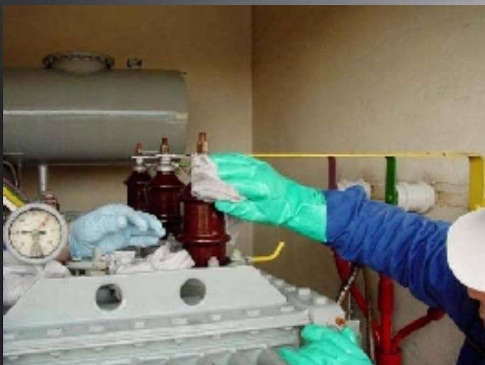
ОЧИСТКА ЭЛЕКТРИЧЕСКОЙ ЧАСТИ ТРАНСФОРМАТОРА, ИЗОЛЯТОРОВ СОСТАВОМ **FIXEL TEC (TOP ELECTRO-CLEANER)** С ПРИМЕНЕНИЕМ БЕЗВОЗДУШНОГО РАСПЫЛИТЕЛЯ
